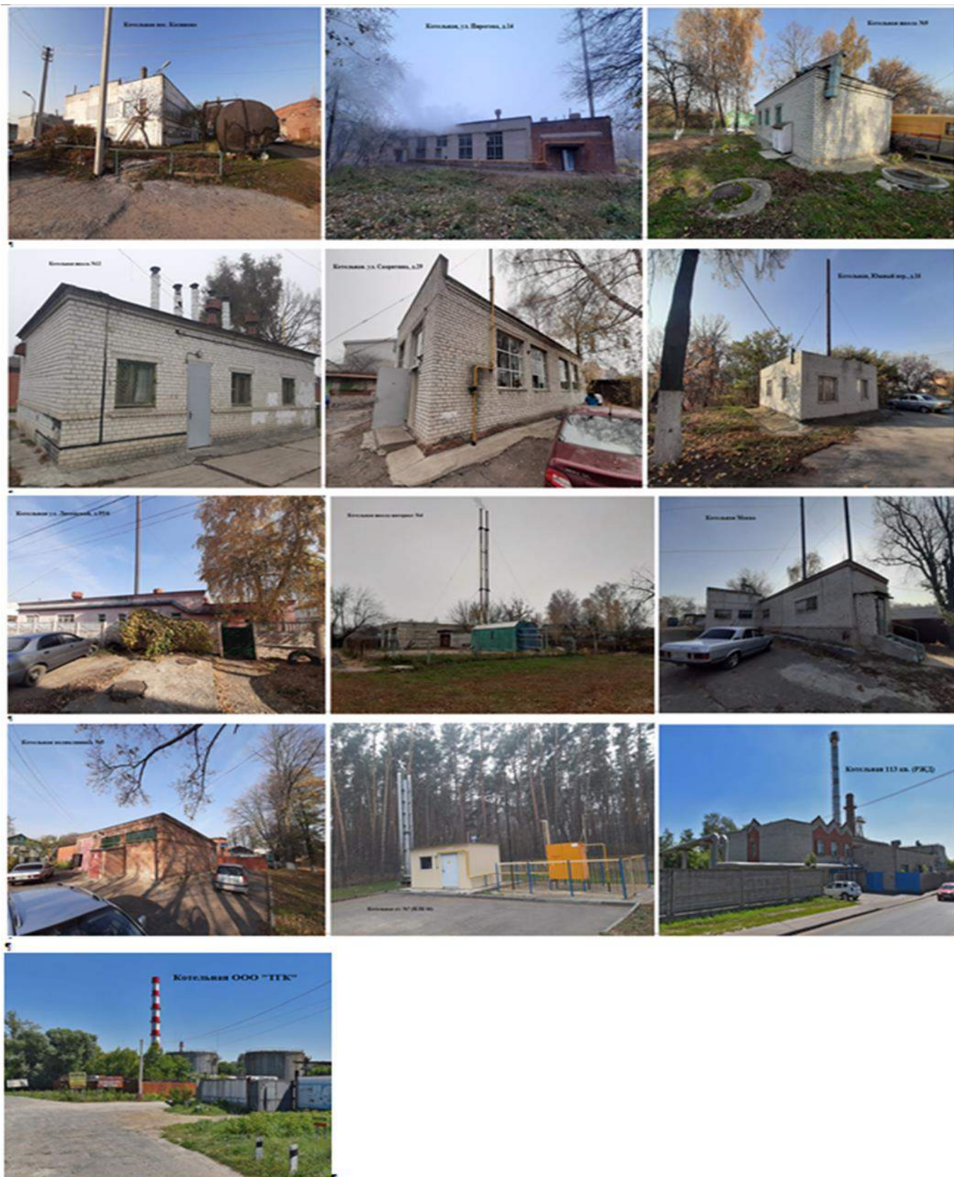
Рисунок 6 – Общий вид котельных эксплуатируемых МУП «Гортеплосеть» и ООО «ТГК»
