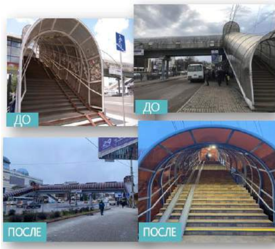
Ремонт надземного перехода по ул. Дзержинского
